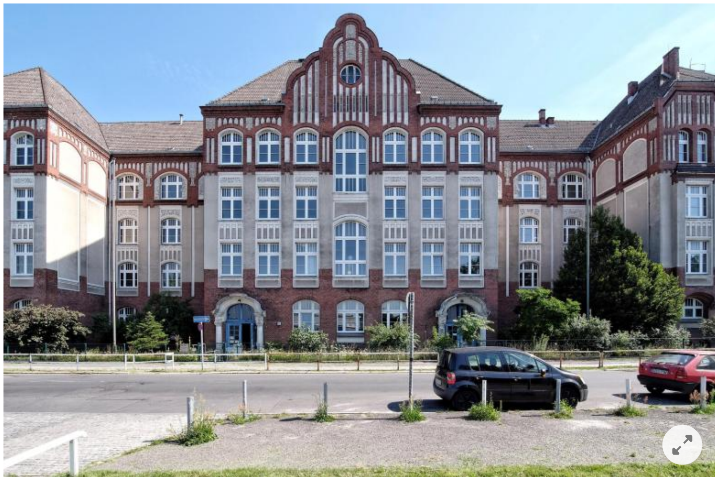
Blick auf die Hauptseite des Gebäudes
