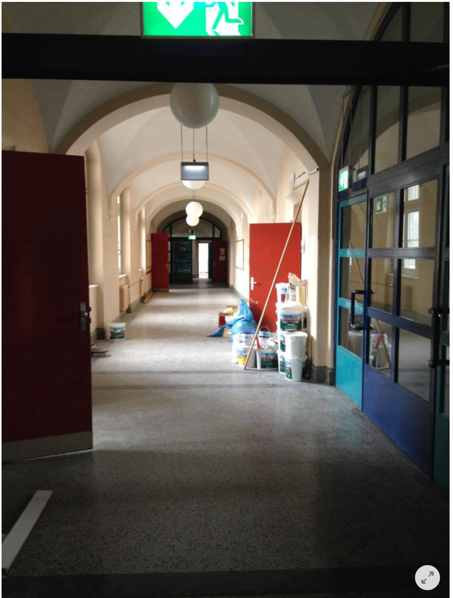
Blick in den Gang im Erdgeschoss. Hier wird renoviert
